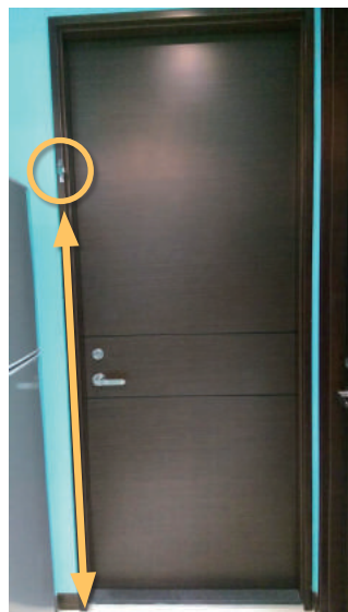
▲ 廚房門緊閉，並將鑰匙懸掛在離地面 110 公分以上的牆面上
