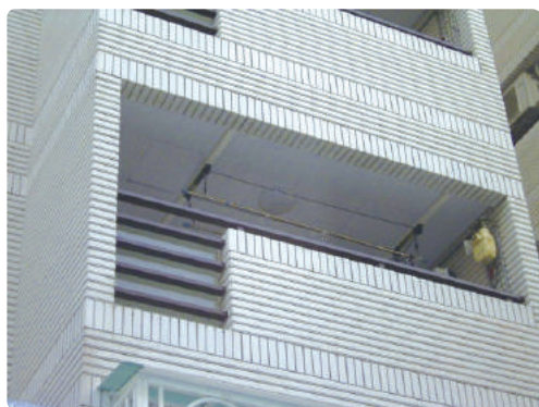
▲ 使用隔板或壓克力板從內側將欄杆整面封住
