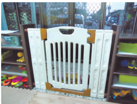
▲ 通往室外門之內側加裝柵欄
