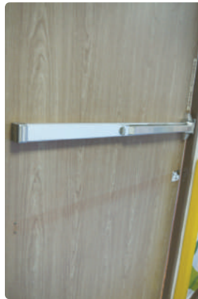
▲ 逃生門狀況良好，堅固且無剝落、生鏽
