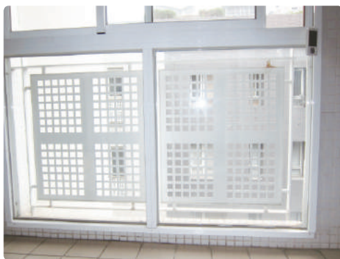
▲ 使用隔板或壓克力板從內側將欄杆整面封住
