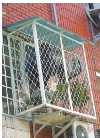
▲ 窗戶整體裝設護欄，如：鐵窗
