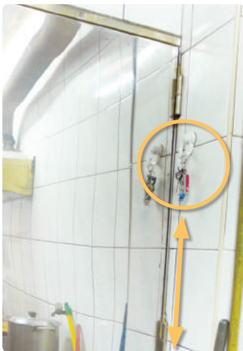
▲ 逃生門狀況良好，堅固且無剝落、生鏽
