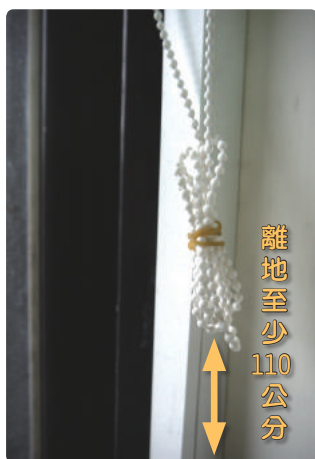
▲ 橡皮筋綁住拉繩
