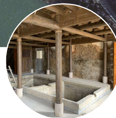
橋仔五間排歷史建築修繕
