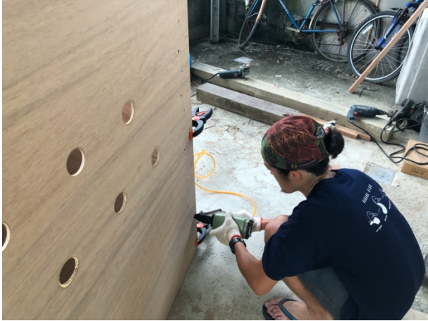
圖五、結構完成後，使用釘槍將運輸籠每面確實固定。
