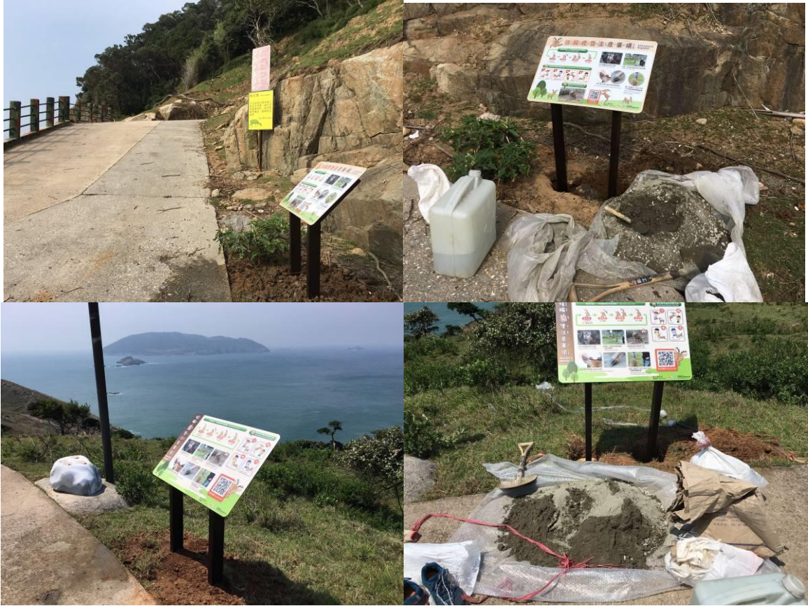
圖 6-35、解說告示牌現場施工照片
