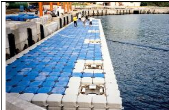
綠島南寮漁港浮動平台
