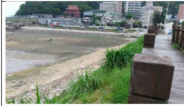
濕地內機具清潔垃圾及垃圾攔截網架設後
