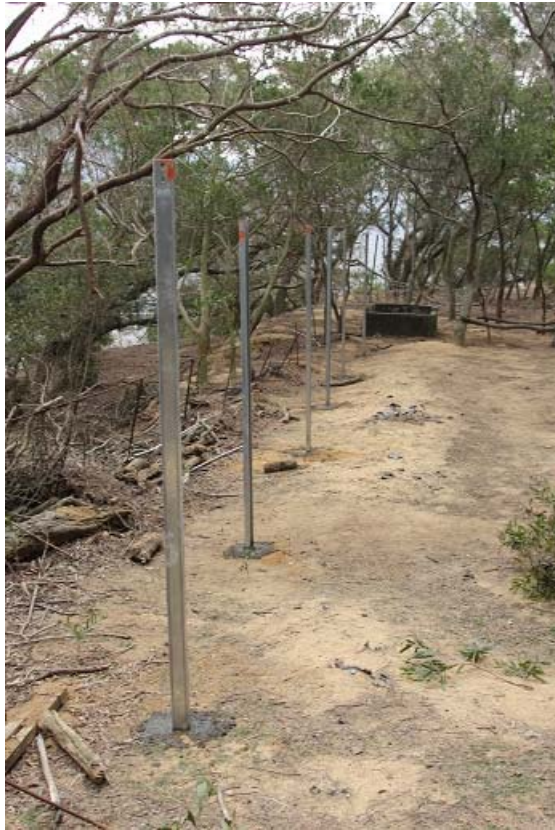
10.將立好的 C 型鋼灌水泥固定。
