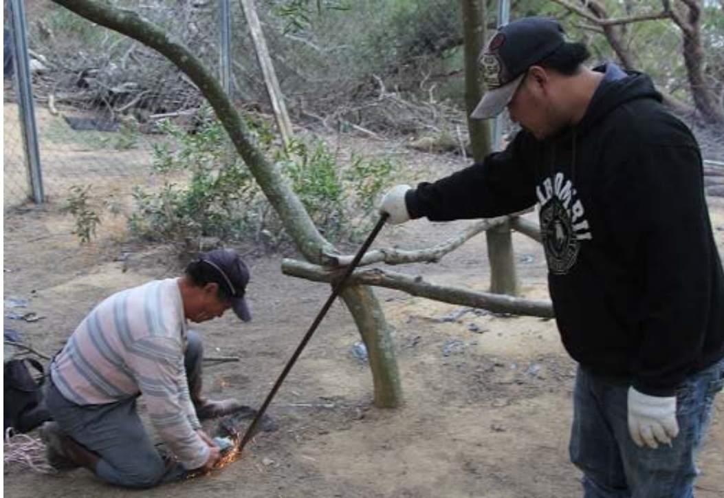
14.拆除舊有圍籬鋼條。
