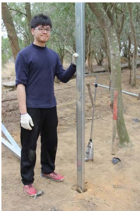
9.使用打洞器具挖洞放至 C 型鋼。
