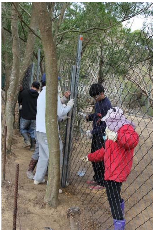
11.將菱形網圍繞 C 型鋼並固定。
