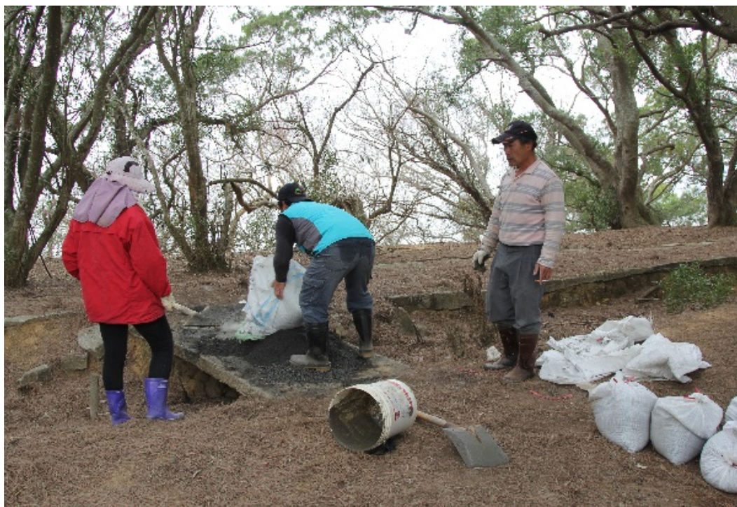
8.現場調和水泥砂石灌住鋼柱基座。
