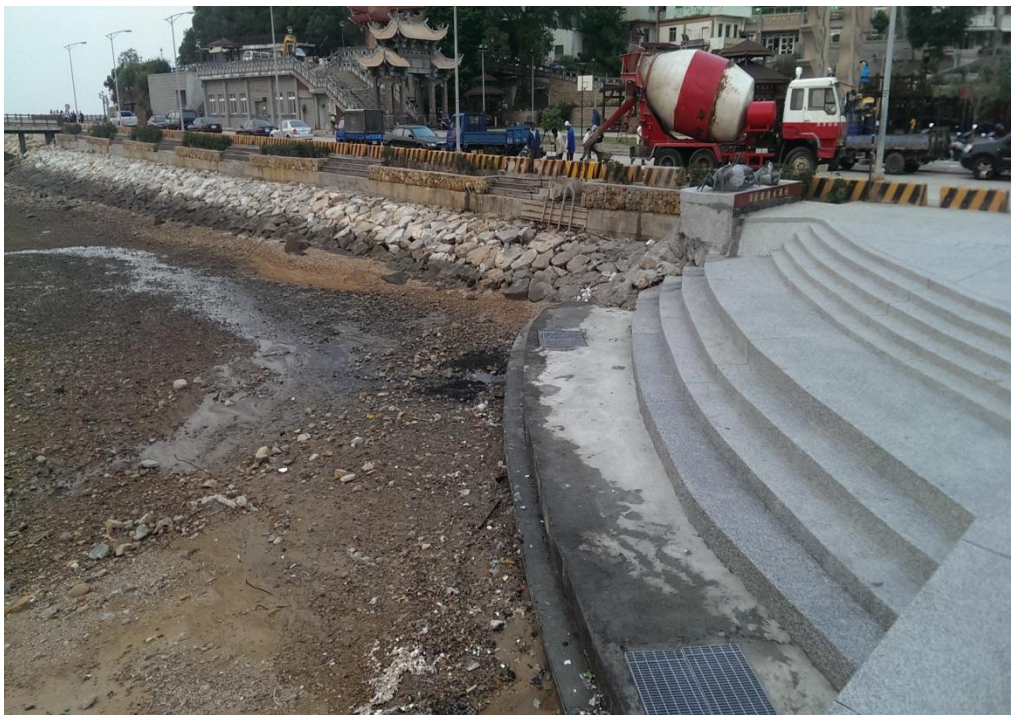
圖 10、入口生活廢水排水之修補工程
