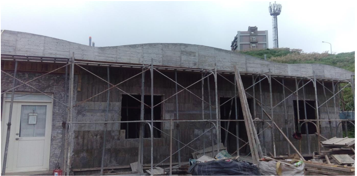
加油站外觀照片2-須含泵島設施 (建築物修繕工程中)
