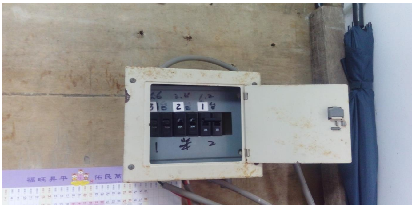
加油站照片8-說明： 臨時配電盤
