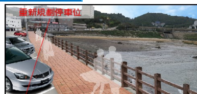
濕地旁增設停車空間
