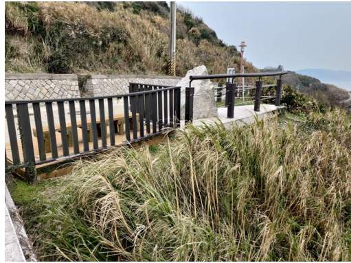
現況說明：觀景平台高低差，基礎結構使用年限過久。
