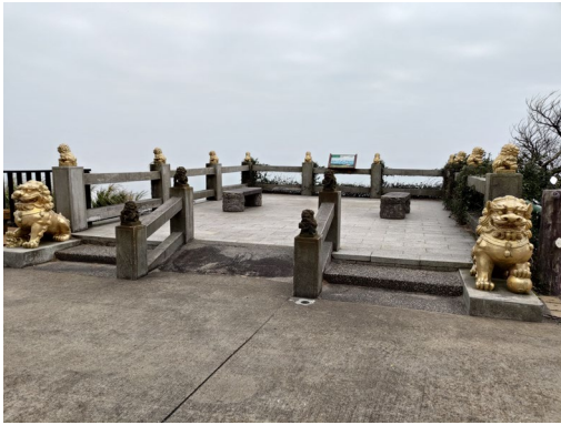
現況說明：觀景平台高低差，基礎結構使用年限過久。
